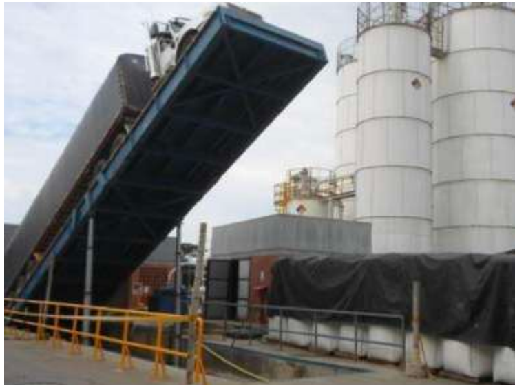
DESCARGA DE LINERS
