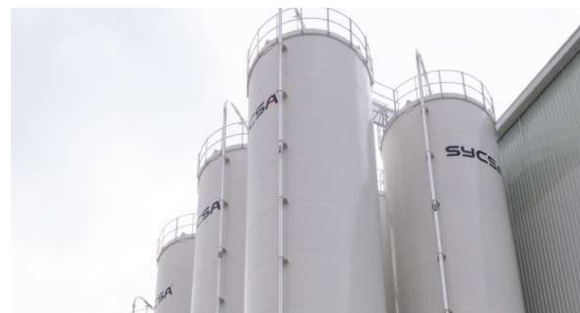
SILOS DE ALMACENAMIENTO
