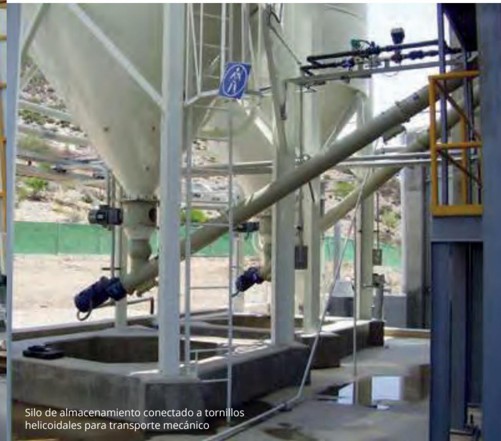
Silo de almacenamiento conectado a tornillos helicoidales para transporte mecánico
